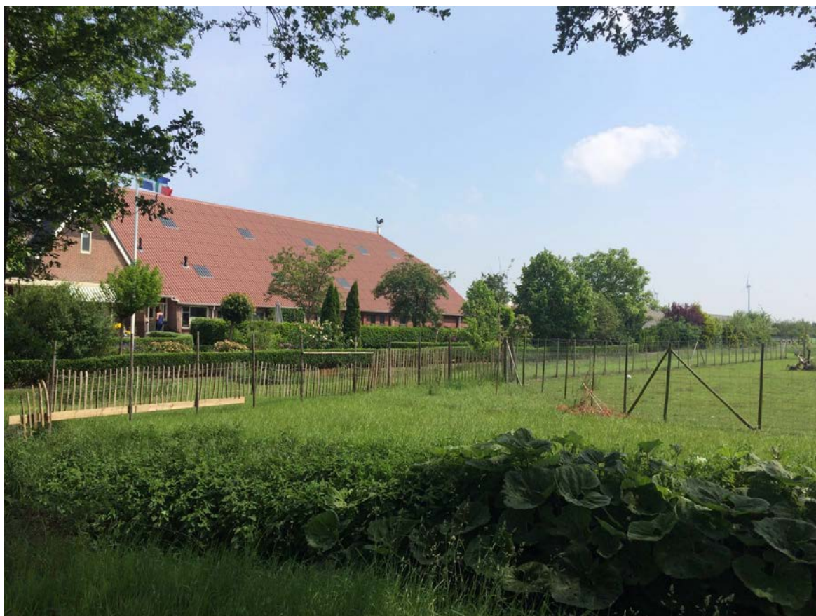
Figuur 2-8 Zijaanzicht locatie, vanaf de Burgemeester Buiskoolweg in noordelijke richting (Bron: Google Earth)
