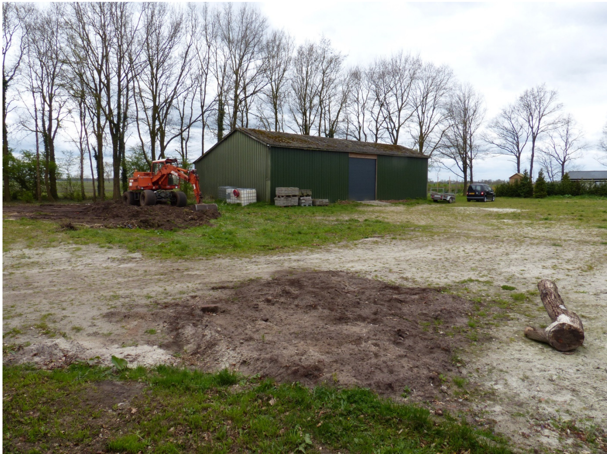
Schuur wordt niet afgebroken.
