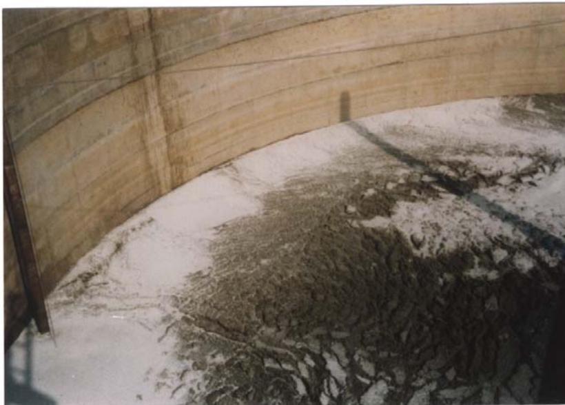
Geschlossene Schwimmdecke selbst beim Rührvorgang
