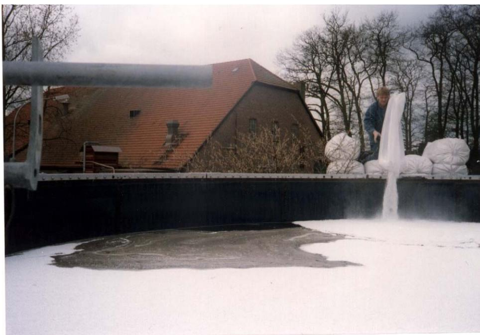
Einfachste Handhabung: Landwirt beim Abdecken eines Güllebehälters mit PEGÜLIT<sup>®</sup>
