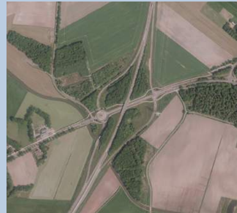
Ombouw knooppunt N34-N391
