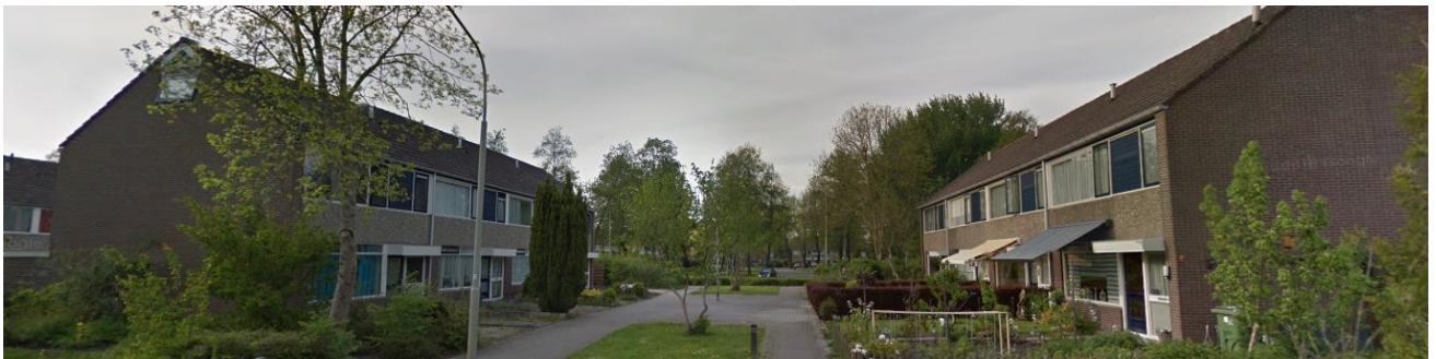
Figuur 1.11 Voorzijde woningen Kleine Belt 37 t/m 43 en voor-/linkerzijde woningen 45 t/m 51 te Delfzijl (Bron: GoogleMaps)
