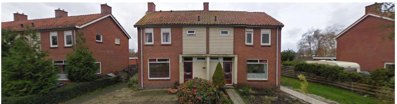
Figuur 1.49 zijaanzicht woning Pijlkruidstraat 37, voorzijde woningen 33 en 35, zijaanzicht woning 27 te Wildervank (Bron: GoogleMaps)
