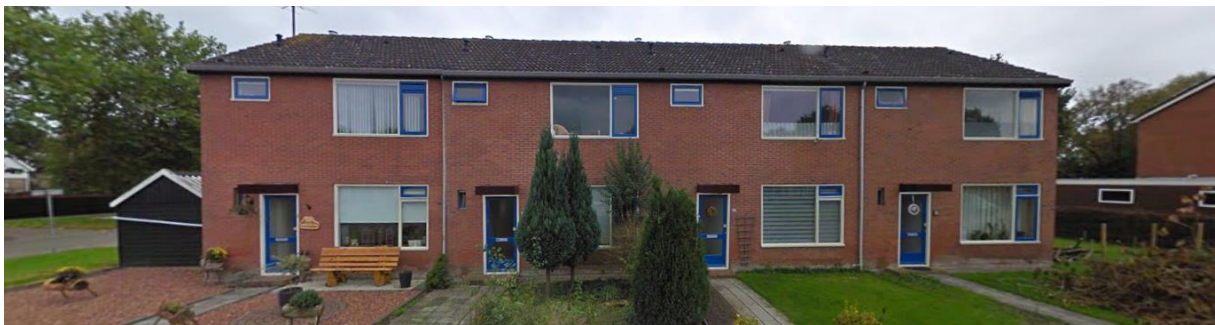
Figuur 1.18 Voorzijde woningen Havenweg 44 t/m 50 te Spijk (Bron: GoogleMaps)
