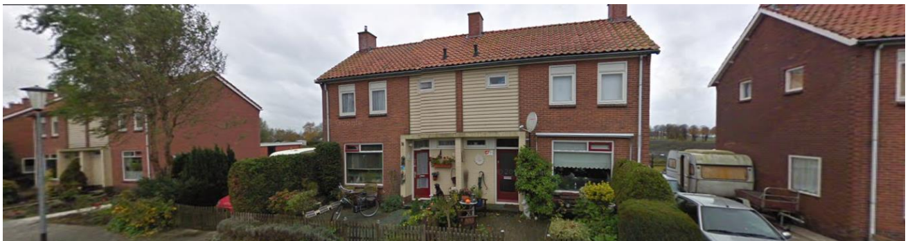
Figuur 1.48 zijaanzicht woning Pijlkruidstraat 23, voorzijde woningen 25 en 27, zijaanzicht woning 33 te Wildervank (Bron: GoogleMaps)
