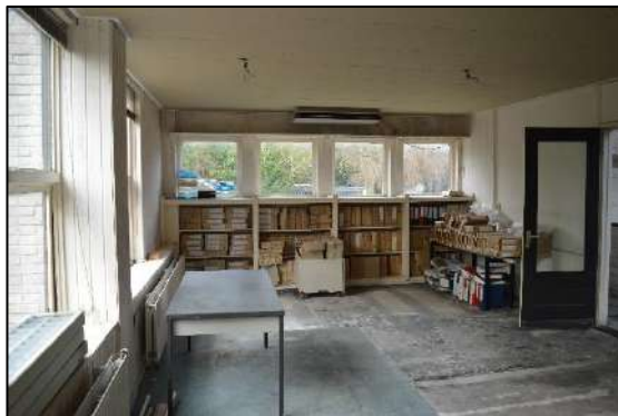
Afbeelding 2.14. Opslagruimte westelijke pand.
