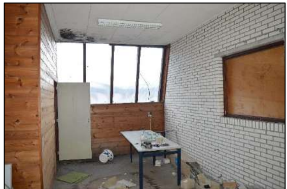
Afbeelding 2.7. Eerste verdieping oostelijke pand.
