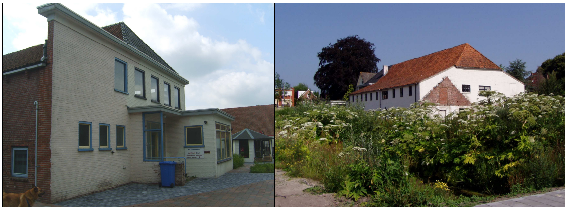
Voorzijde gebouw, zuidelijke richting
