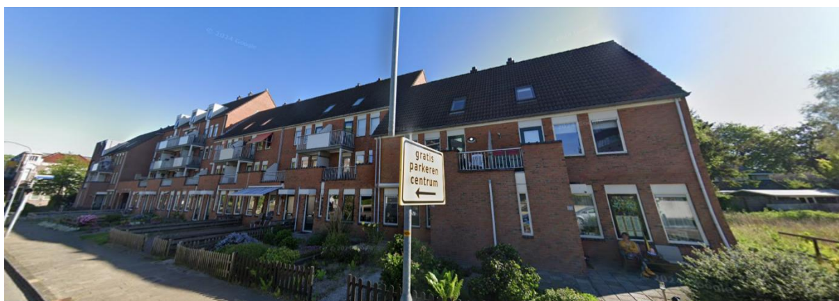
Figuur 4: zicht naastgelegen bebouwing
