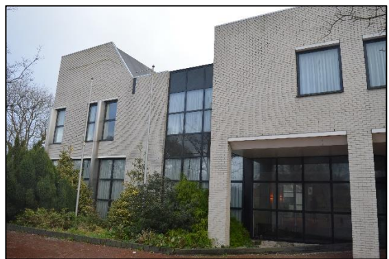
Afbeelding 2.5. Buitenzijde pand gezien vanaf noorden.
