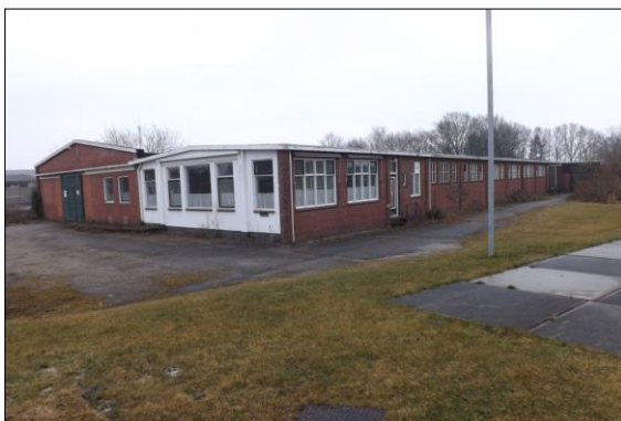
Te slopen bebouwing noordzijde plangebied
