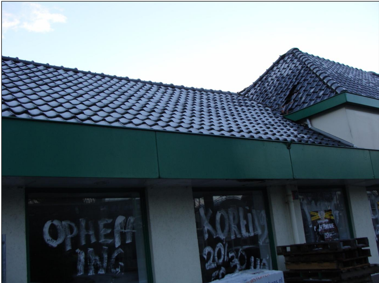
Figuur 7. Het dak van een deel van het pand is voldoende hoog en steil voor gierzwaluw. Ook zijn op deze foto losgeraakte dakpannen te zien.
