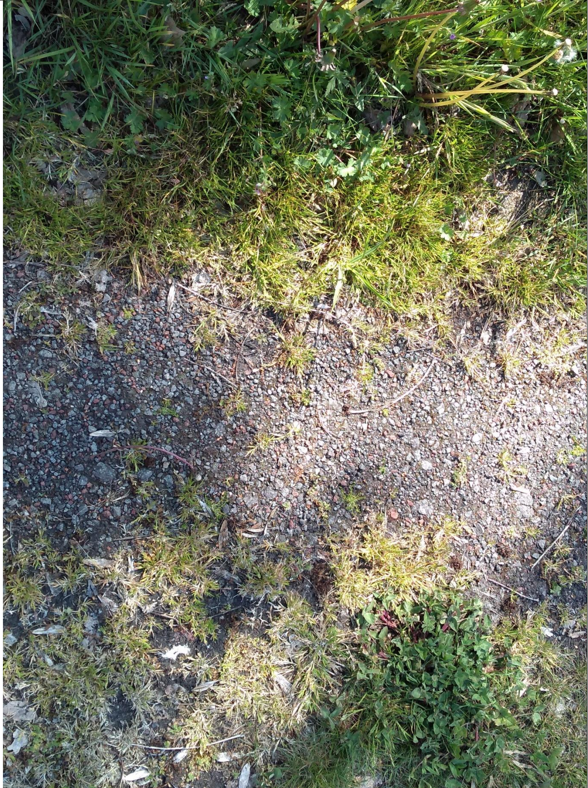
Foto 4: puinpad op op oostelijk locatiedeel
