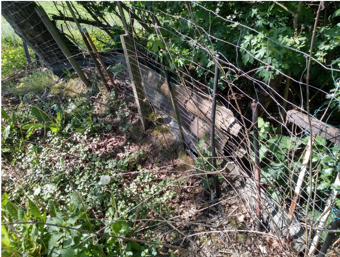
Foto 12: asbestverdacht plaatmateriaal op zuidelijke locatiedeel
