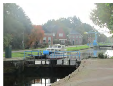
sluisje Dokter H. Brouwerstraat
