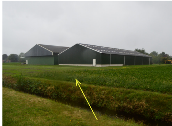
1.6 Zicht vanaf de Participantenweg op huidige bebouwing. Vanaf de N33 zijn beide schuren zichtbaar.
