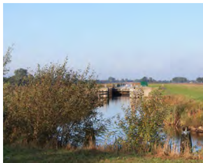
nieuwe sluis ontsluit zeilplas Langebosch
