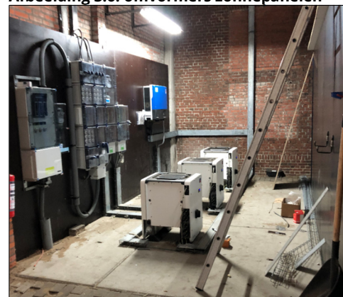
Afbeelding 3.6: omvormers zonnepanelen
