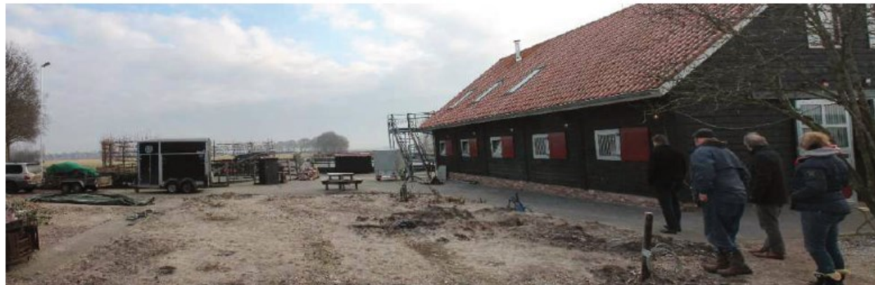
zicht over beoogde locatie voor herbouw zorgwoning
