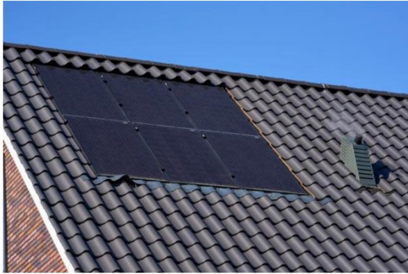
Hellend dak met in het dakvlak geïntegreerde zonnepanelen oplossing voor platdak
