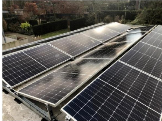
Hellend dak met in het dakvlak geïntegreerde zonnepanelen oplossing voor platdak
