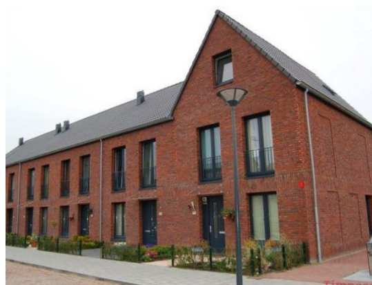
Eenvoudige, sterke gevelritmiek
