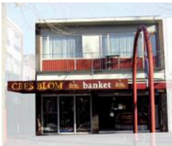
Gewelbeeld wordt verstoord door luifel (voor de verbouwing)
