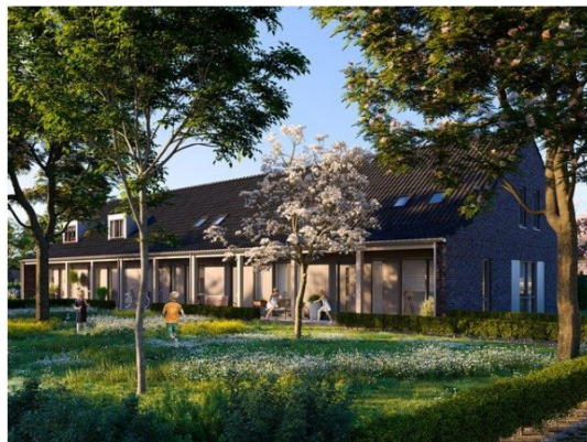
Een extra dakoverstek maakt woningen aantrekkelijk
