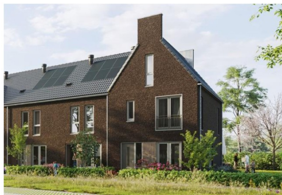
Eindwoning met tuitgevel
