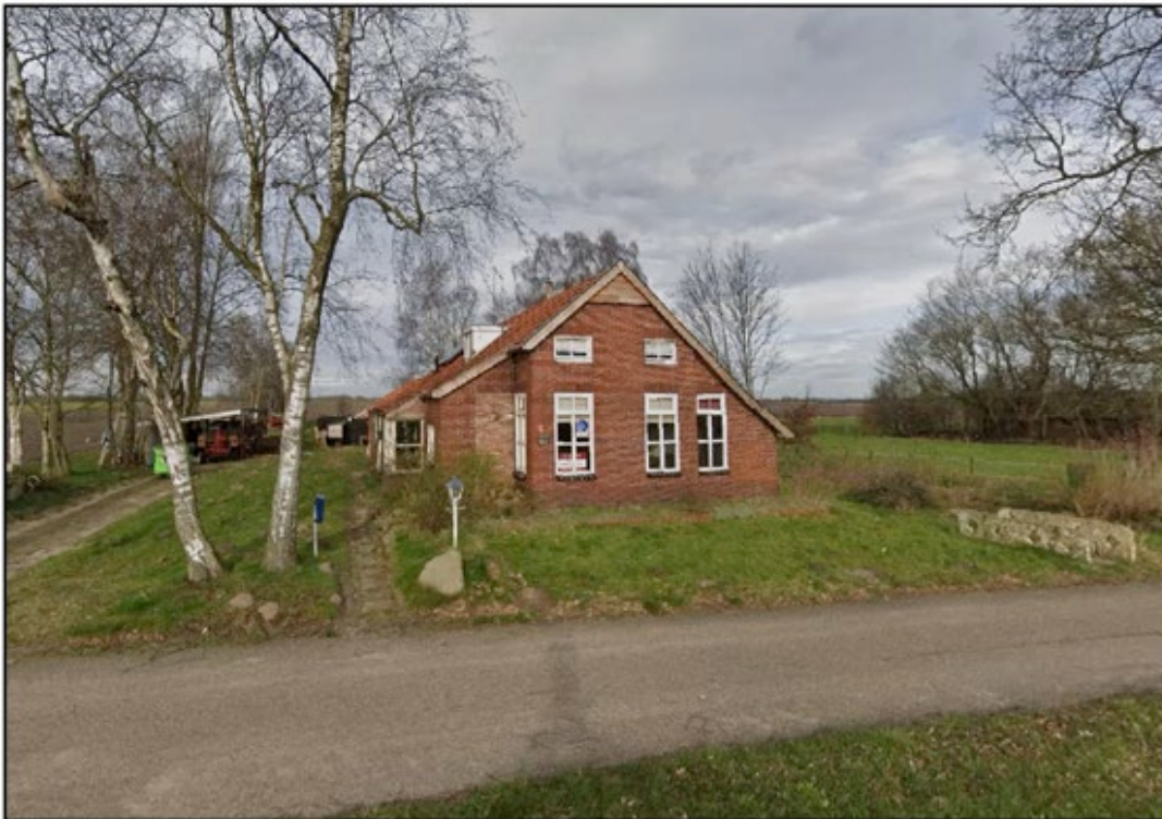
Afbeelding 2.1: Straataanzicht plangebied (Bron: Google Streetview)
