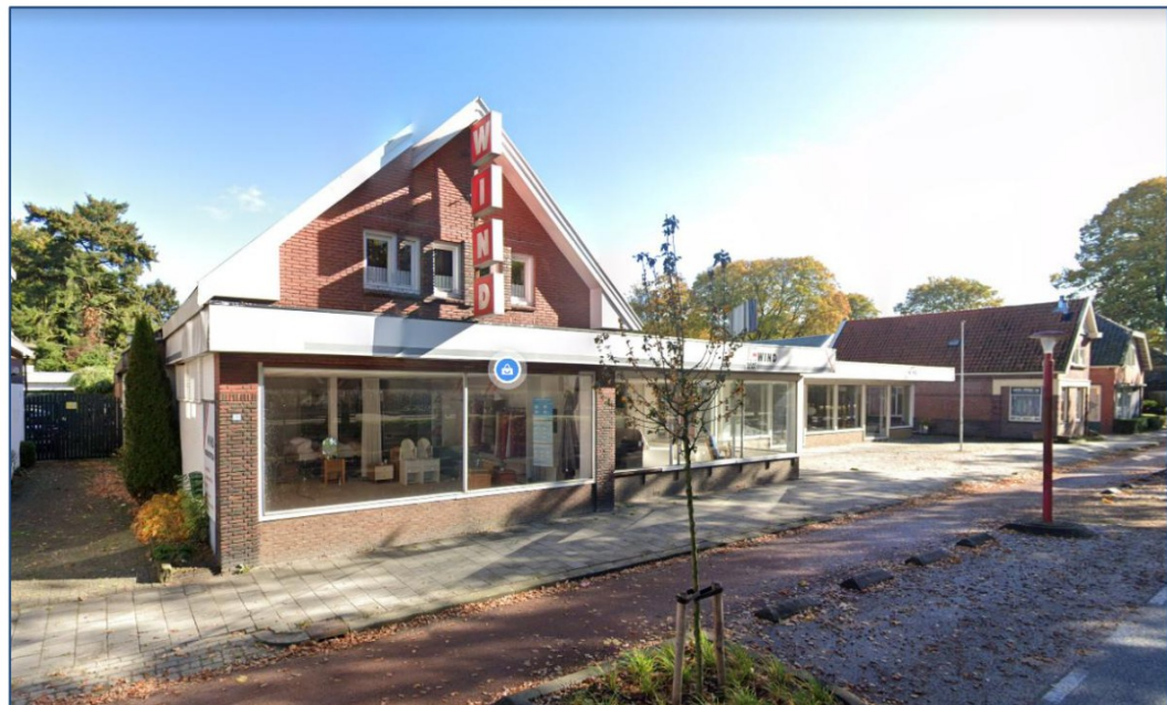
Fig. 2.4 Een weergave van het werkingsgebied gezien van de Sluisstraat, met zicht op het (te slopen) bestaande woonwinkelpand. Voorheen was hier sprake van Wind Woninginrichting.
