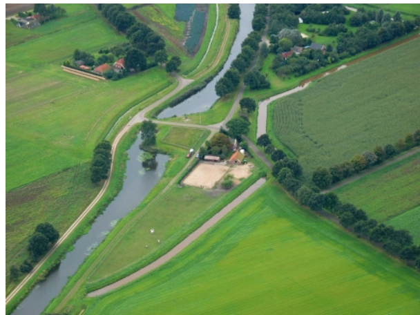
luchtfoto van locatie vanuit het noordoosten
