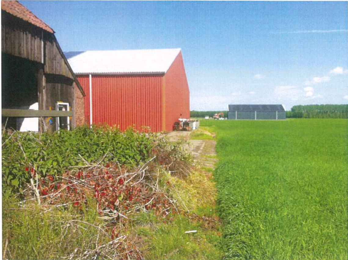
Figuur 3 locatie te bouwen aardappelbewaarplaats, achter de 2 bestaande schuren.
