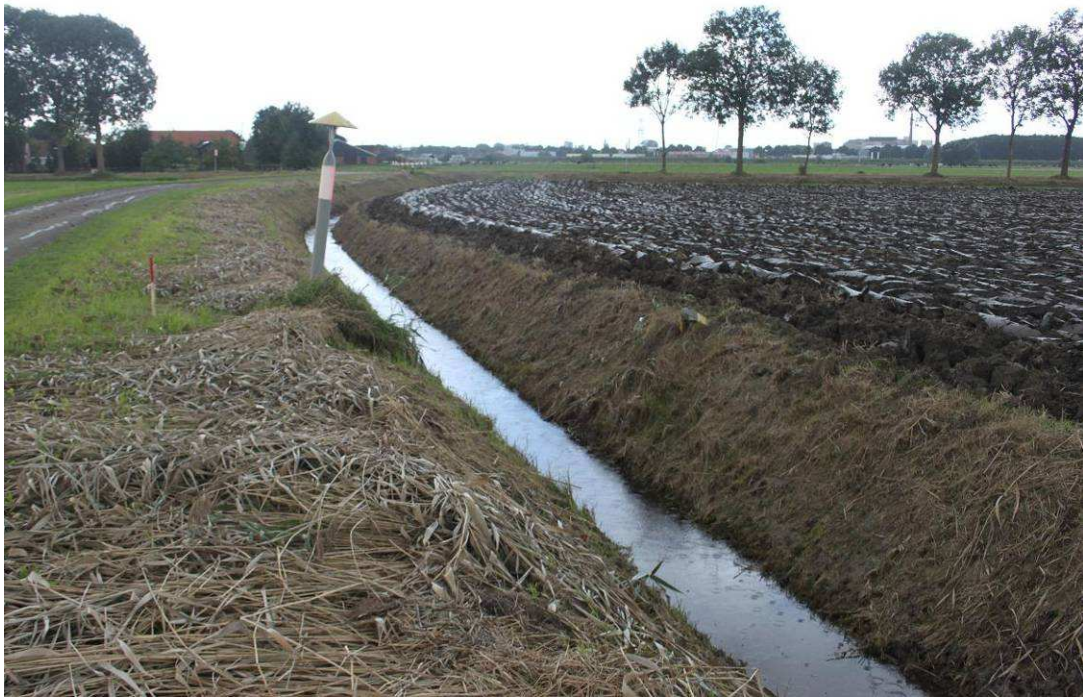
figuur 3.6. Foto van watergang langs de Venneweg waar de zinker vervangen gaat worden.
