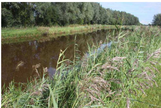
Figuur 3.8: Foto raailocatie 2, modificatie 0 (september 2013)
