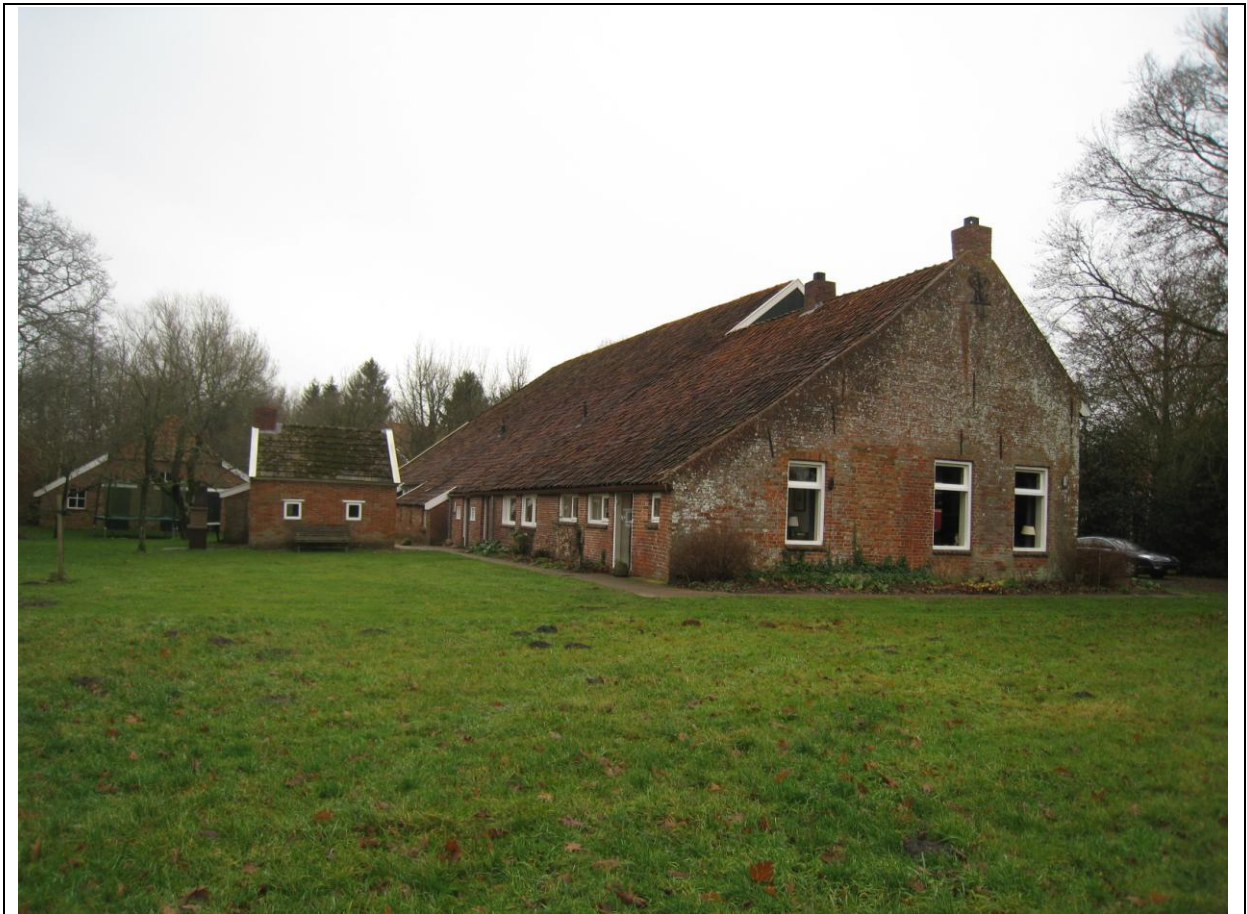
Afbeelding 3: Links de bijschuur achter bosschages, de stookhut met dubbel privaat daarvoor en de boerderij. Bron: Holstein Restauratie Architectuur.
