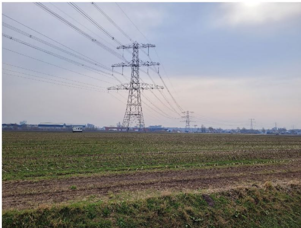
Figuur 1.5 Aan de rechterkant de beoogde locatie voor het nieuwe hoogspanningsstation
