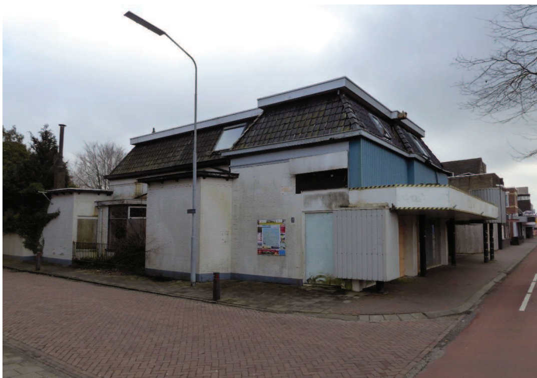
Pandnummer 66 met geschikte verblijfplaatsen voor vleermuizen.
