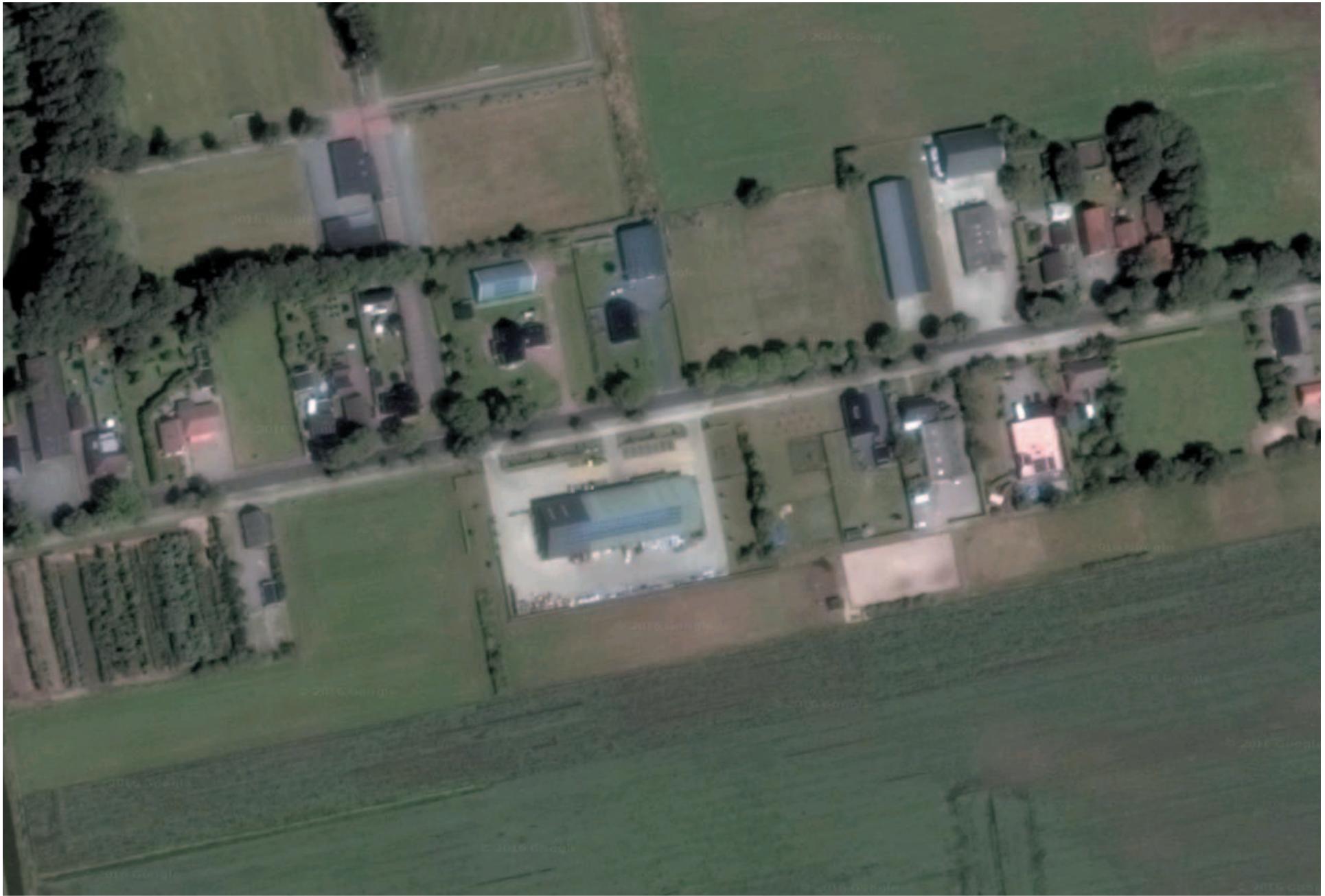
Afbeelding 1. Het huidige erf aan de Zandtangerweg 46, Mussel. De schuur met verharding en opslagruimte in de buitenlucht ligt met de rug tegen het open landschap aan.
