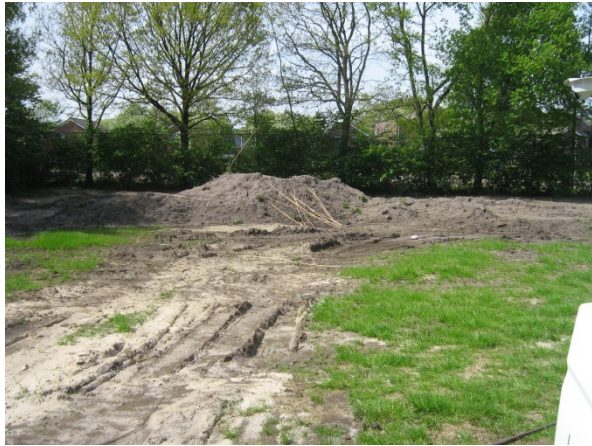
gronddepot t.p.v. de verwijderde asfaltverharding
