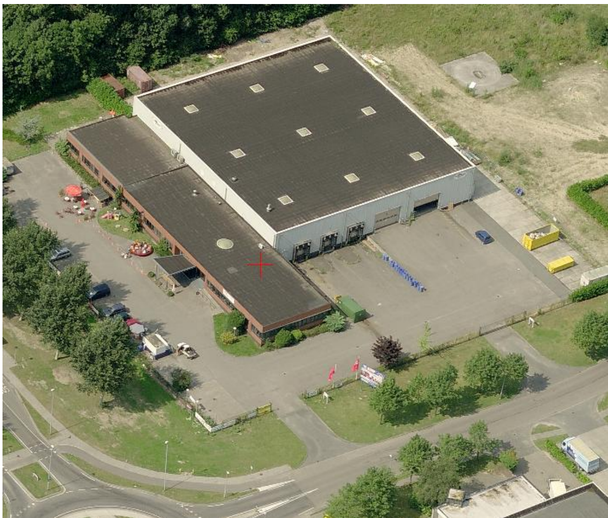
Figuur 2: luchtfoto Bolderweg 50
