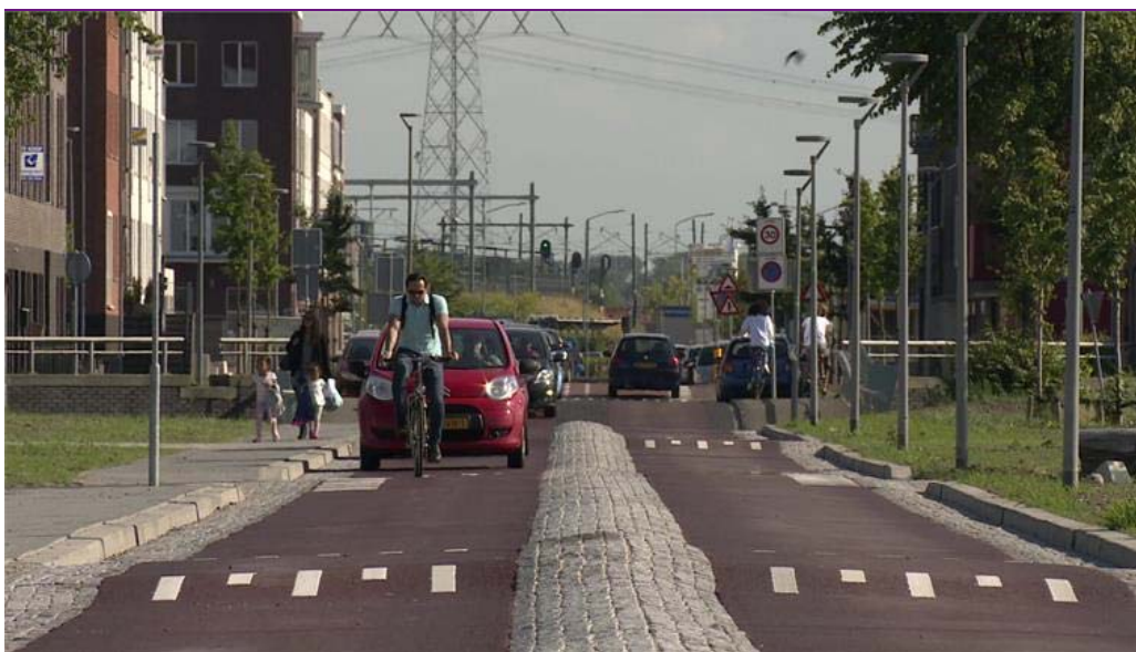
Figuur 1.4 Verkeerssituatie Achillesstraat, Almere
