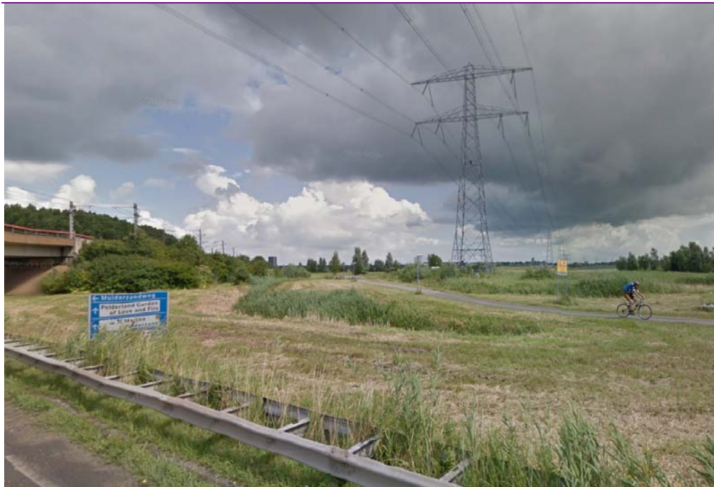
Figuur 5.5 Hoogspanningsverbinding Almere Poort ter plaatse van de kruising Poortdreef/Elementendreef en het spoor, gezien richting het Spoorbaanpad
