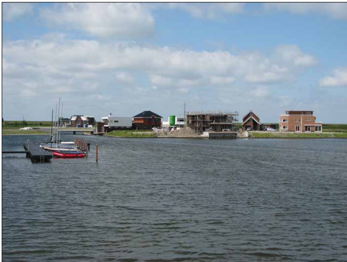
In een deel van plangebied Noorderplassen West vinden bouwwerkzaamheden plaats.
