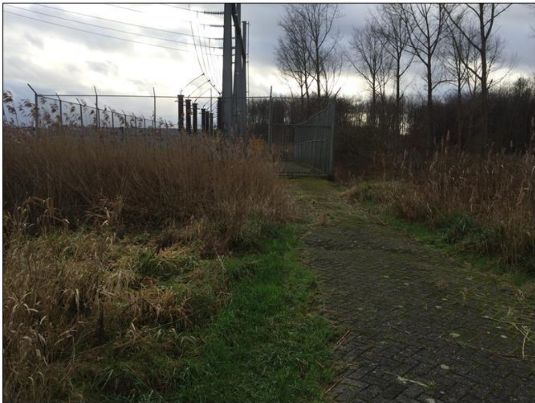
Afbeelding 4. Het aansluitpunt van de hoogspanningsmasten in het plangebied. Er ligt onder en naast het pad reeds een leiding, vanwaar de boring hier (rechts langs het pad) niet is uitgevoerd.
