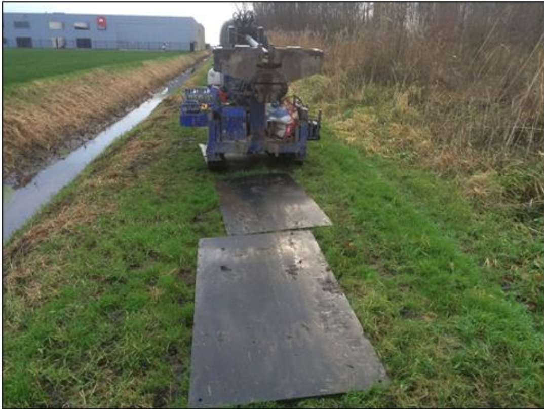
Afbeelding 3. De aqualock onderweg naar het plangebied op rijplaten voor het verkennend booronderzoek.
