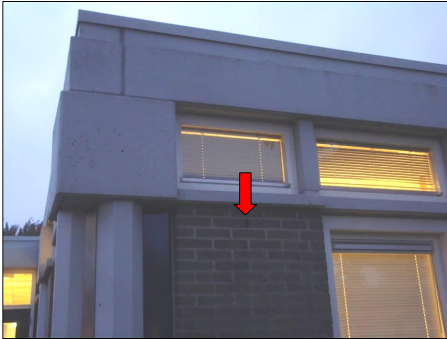
Foto 1: Paarverblijfplaats gewone dwergvleermuis (locatie 1) Het gebouw "Huisartsenpraktijk gezondheidscentrum West"
