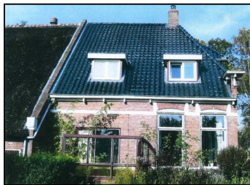
Figuur 4. Overgang tussen woonhuis en rietgedekt achterhuis
