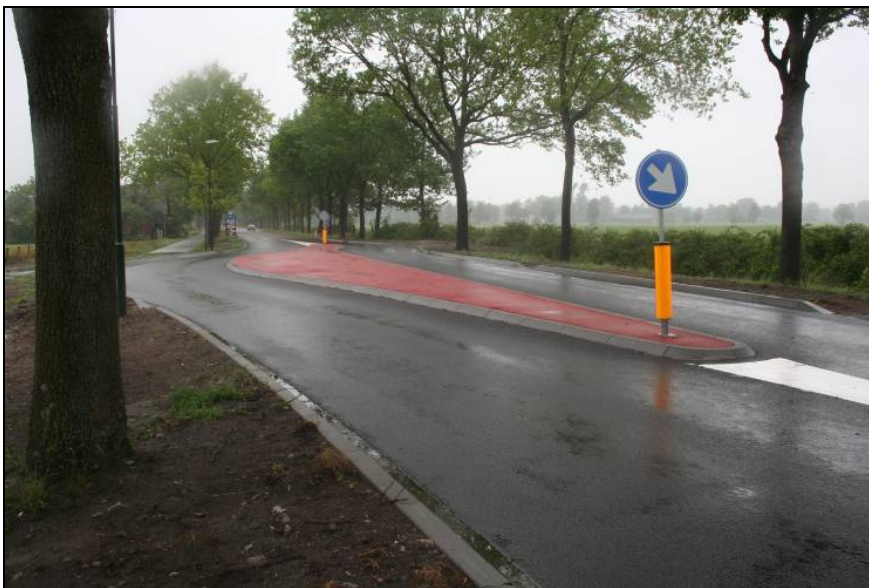
Figuur 4. Uitgevoerde reconstructie provinciale N980 bij nadering Noordwijk
