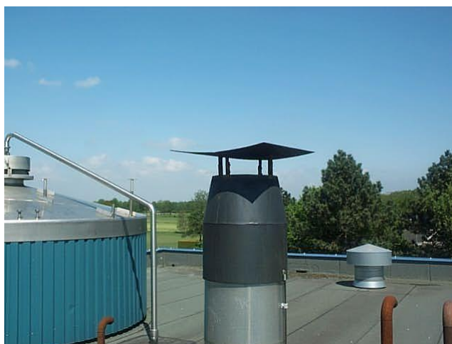
Figuur 4: Schoorsteen emissiepunt
