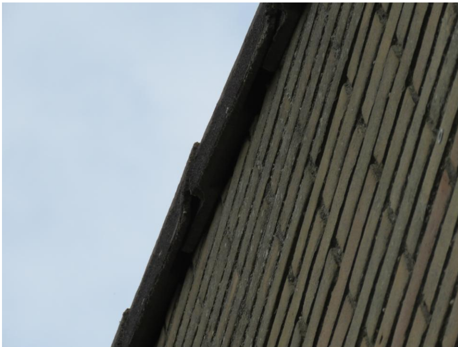
Foto 3 en 4 (A&W september 2015). Bovenste foto: Mogelijke verblijfplaats van Huismus. Onderste foto Mogelijkheden voor vleermuisverblijfplaatsen onder niet aansluitende dakpannen. Deze geven waarschijnlijk ook toegang voor Gierzwaluw.
