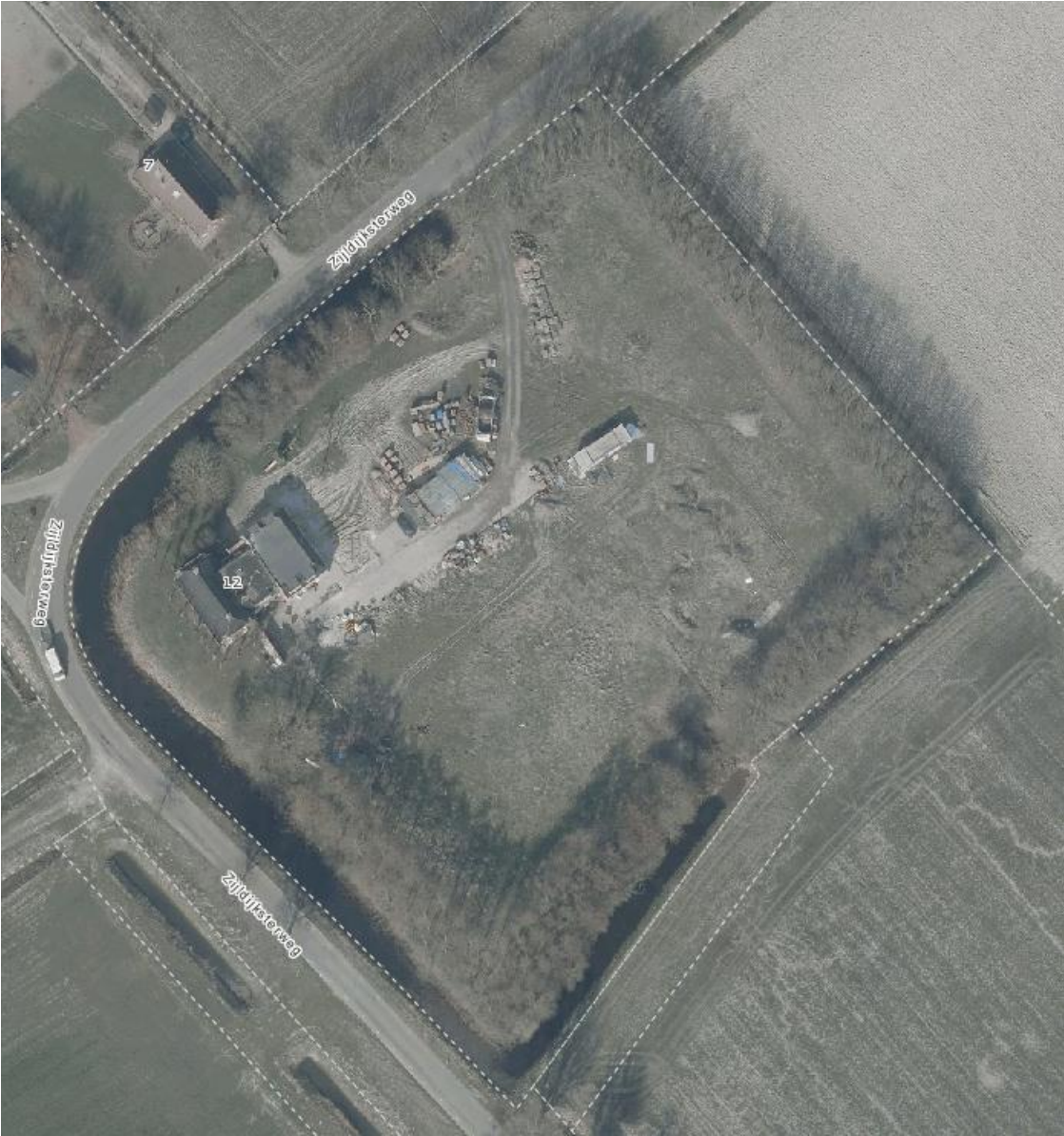
Luchtfoto Zijldijksterweg 12, 't Zandt - bestaande situatie
