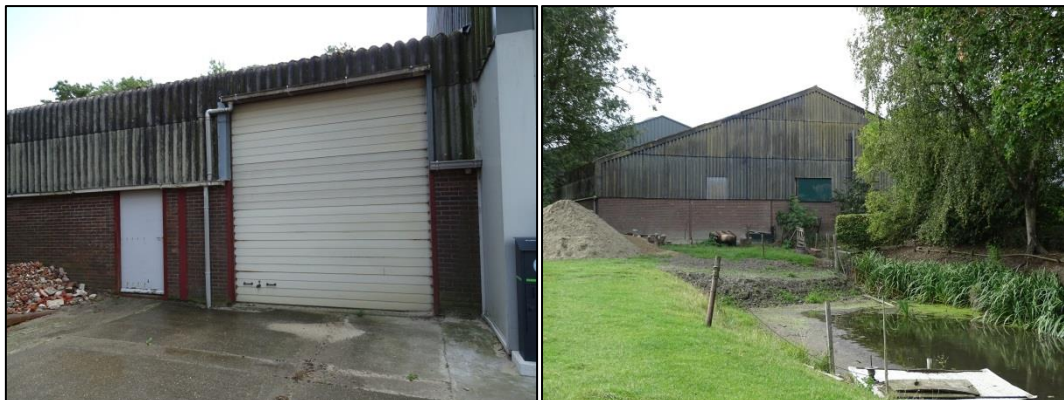
Impressie van het projectgebied op 20 augustus 2019. Foto 1 toont de loods vanaf het westen gezien. Foto 2 toont de kopse kant van de loops vanaf het noordwesten gezien.
