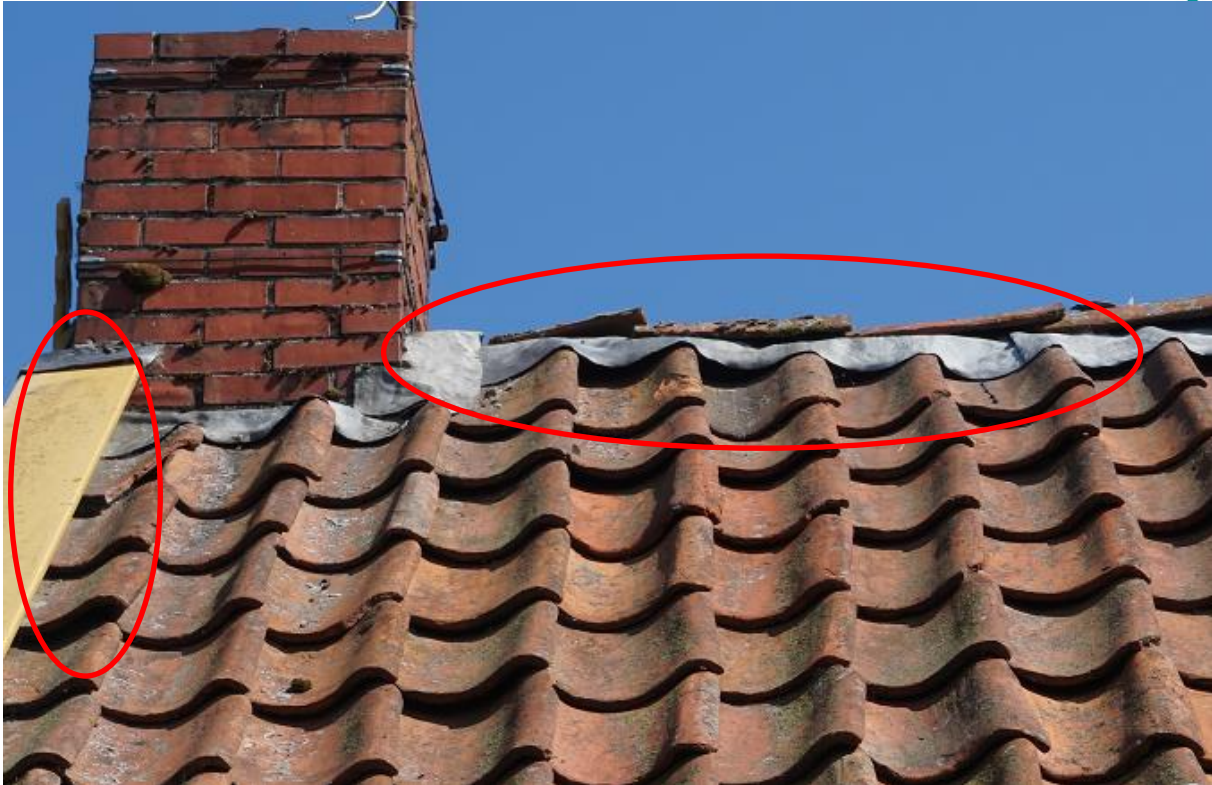
Figuur 5.5. Voorbeelden van potentiële toegangswegen voor vleermuizen in de vorm van ruimte onder nokpannen, loodslabben en waterbord langs de dakrand (westzijde woning).
