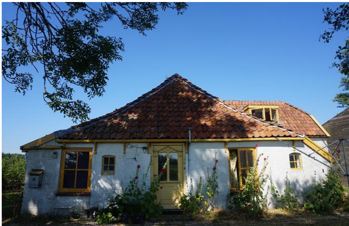
Figuur 2.4. Achteraanzicht (zuidwestzijde) van de woning.
