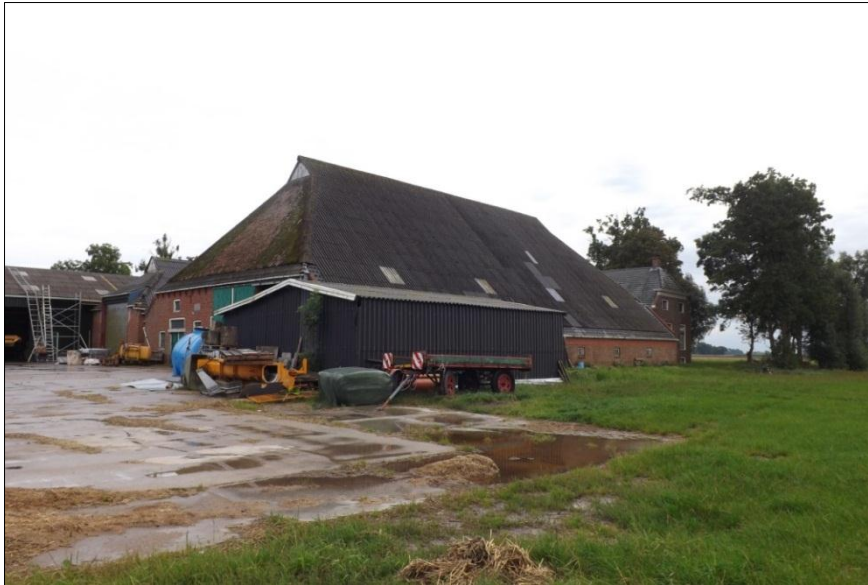
Te slopen schuren vanuit het noorden
