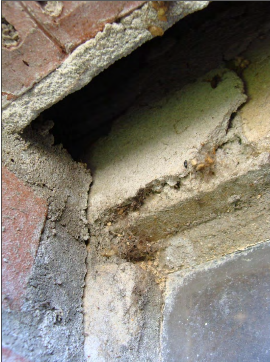
Figuur 10. Vanuit het kozijn voor vleermuizen vrij toegankelijke spouwmuur in één van de te slopen stallen.
