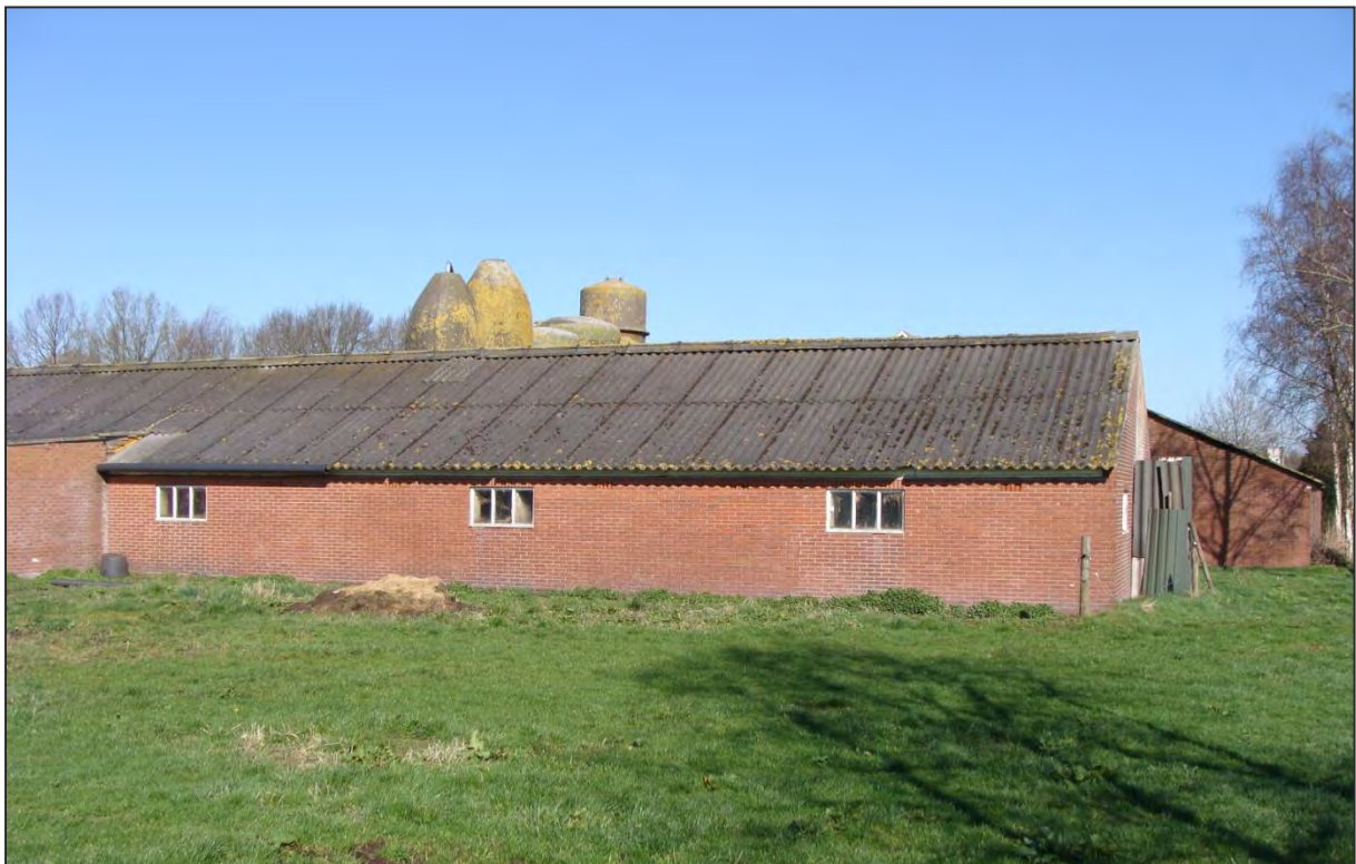
Figuur 4. Achterzijde van één van de te slopen stallen.
