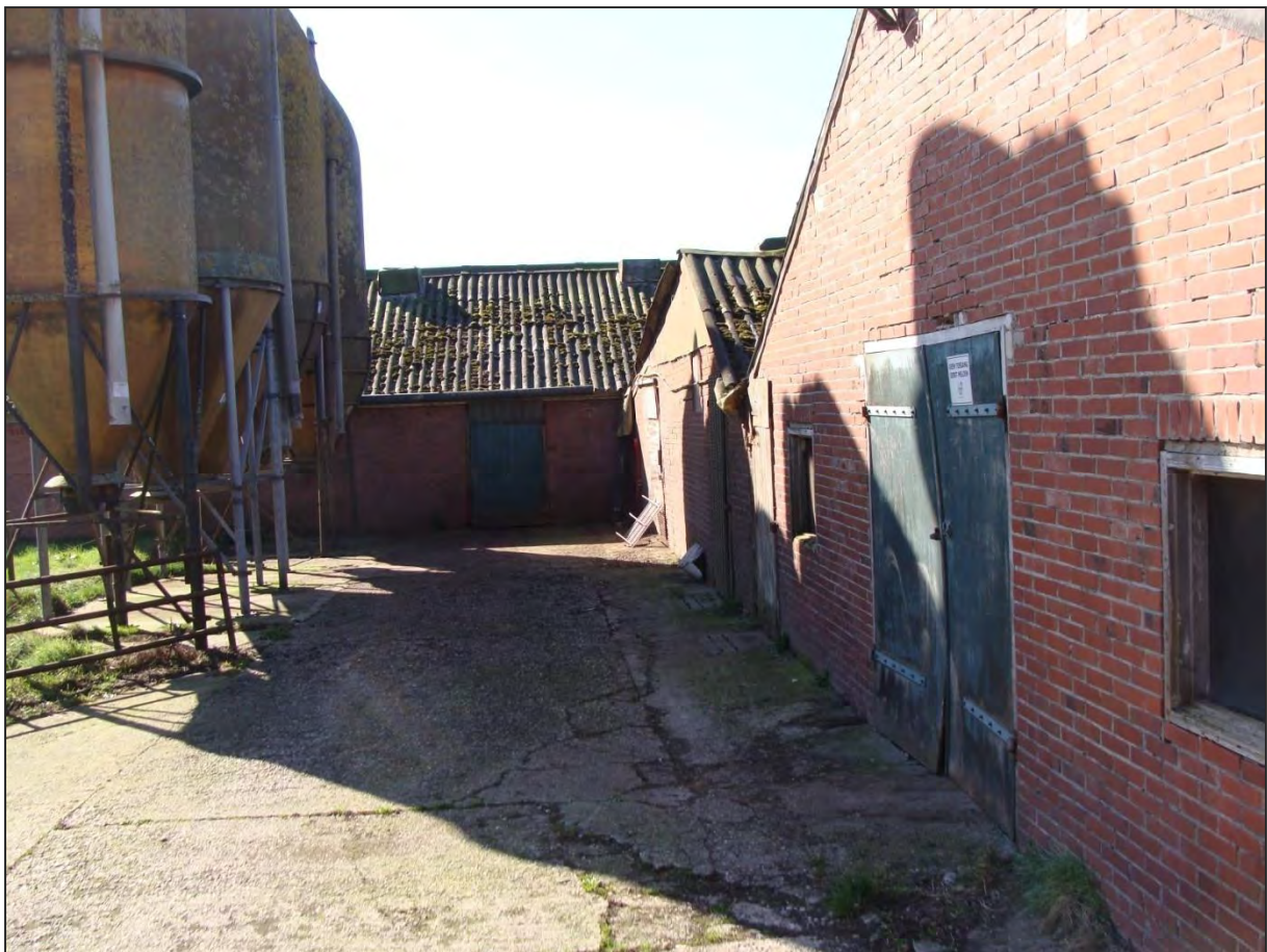
Figuur 3. De drie te slopen stallen gezien vanaf de oprit.
