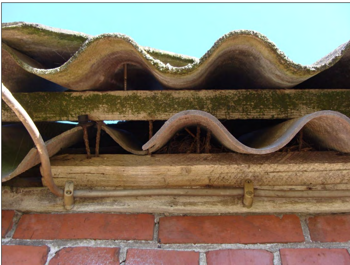
Figuur 9. Nesten onder het dak van de aan het woonhuis gebouwde schuur.
