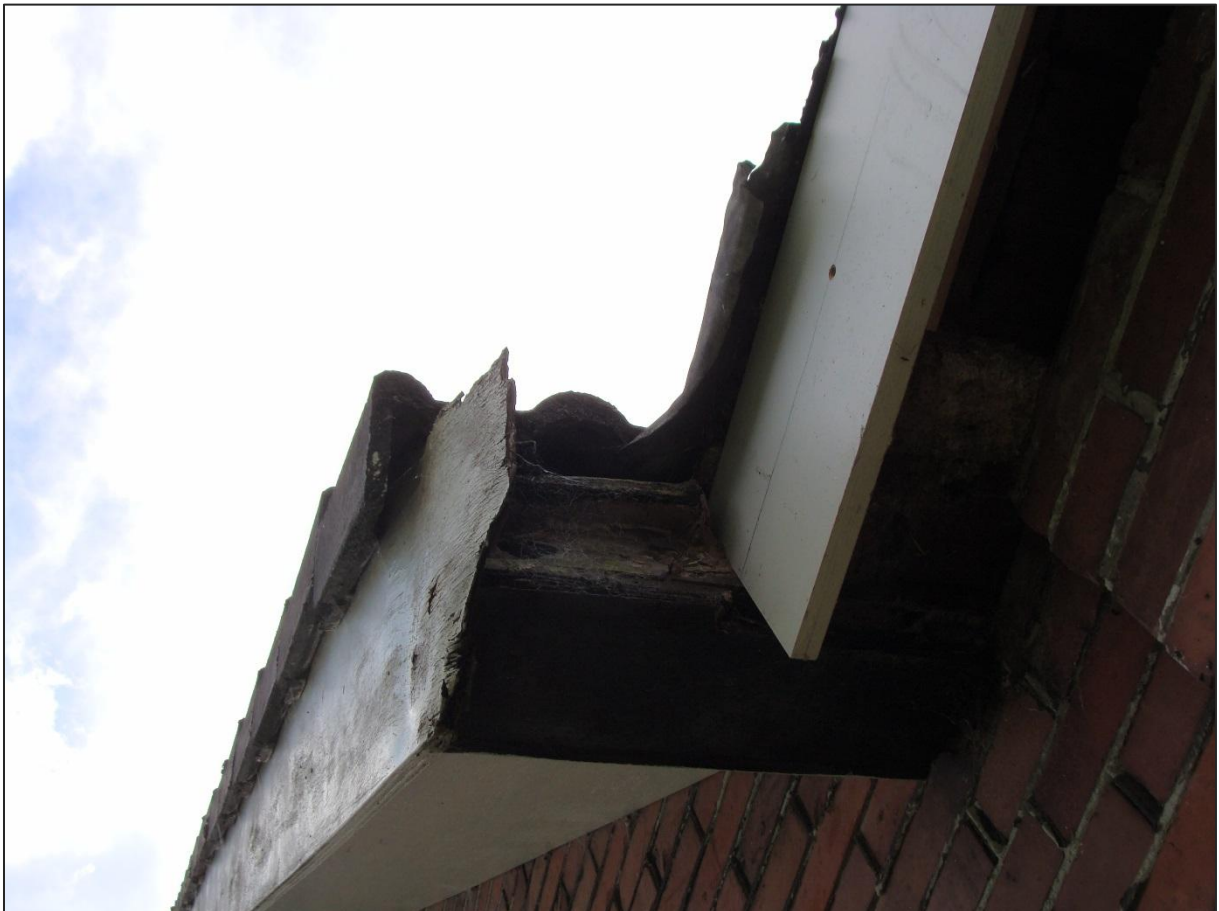
Figuur 9. De woning aan de Midwolderweg laat lokaal ruimte tot de dakconstructie.
