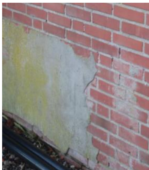
Beeld van de zijgevels, slecht voegwerk, specielaag op metselwerk
