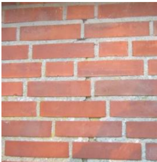
Beeld van de zijgevels, slecht voegwerk, specielaag op metselwerk
