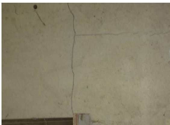
Scheuren in binnenblad op diverse plaatsen waarneembaar
