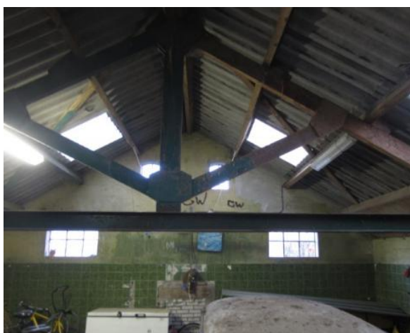
Houtenspant met stalen onderligger. Onderkant van deze ligger op ongeveer 2,0 m+ vloerpeil
