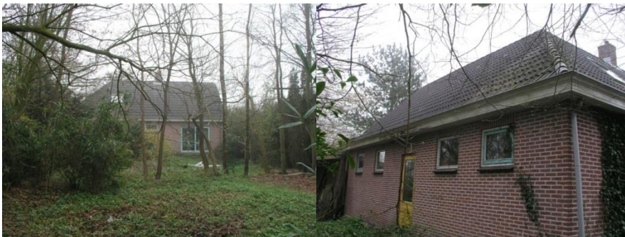
Figuur 1. Impressie te slopen bebouwing (14 april 2016)
