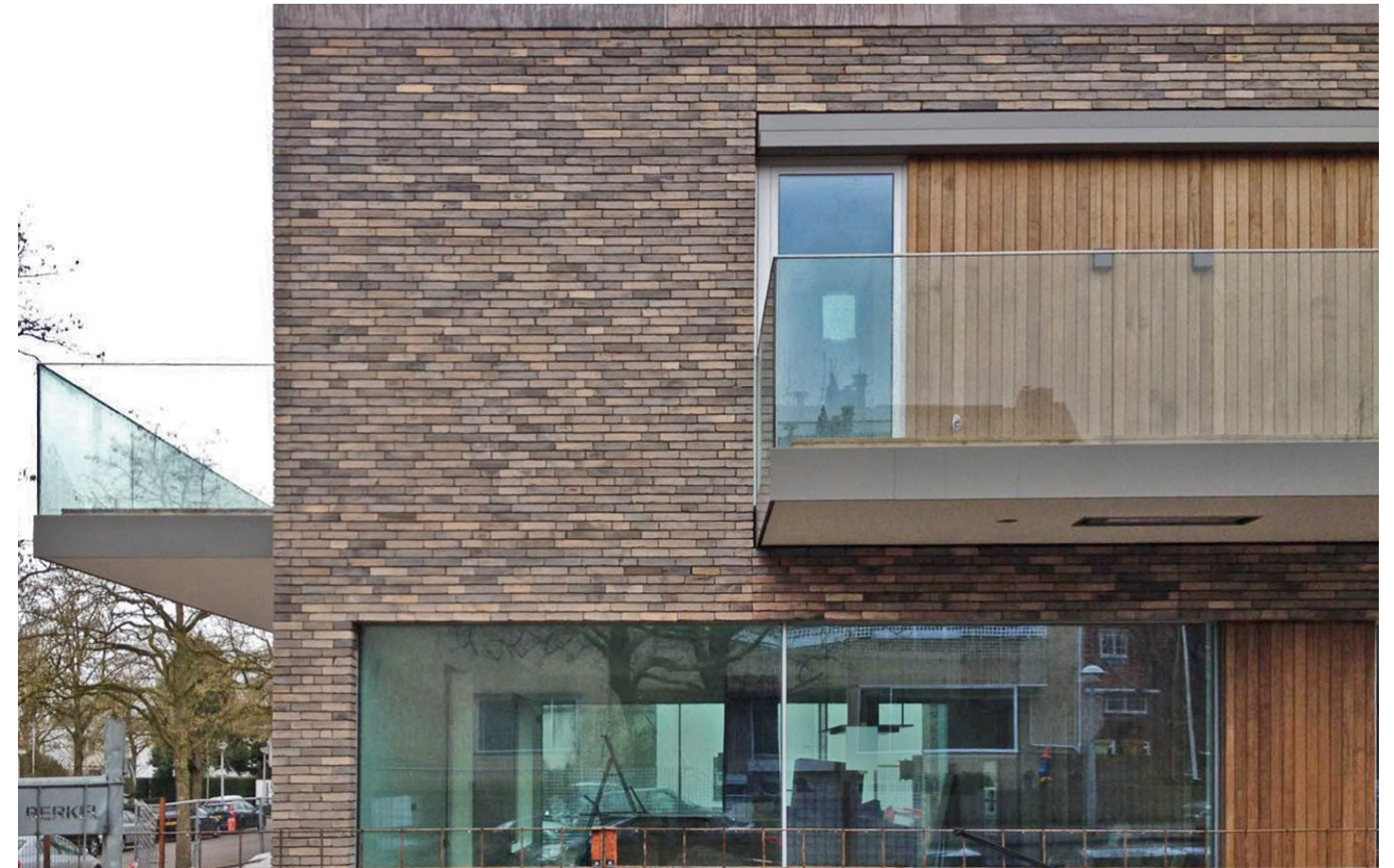
Mooie baksteen, strakke raamvlakken, glazen balkonhek, strak vergrijzend hout
