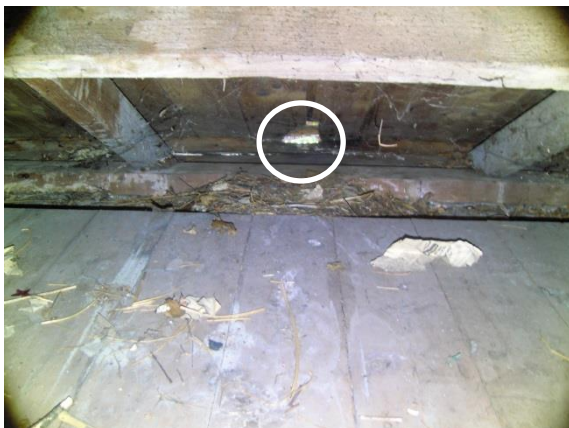
Foto 4 Gat in het dakbeschoot in het oudste deel van het voormalig scholencomplex.
