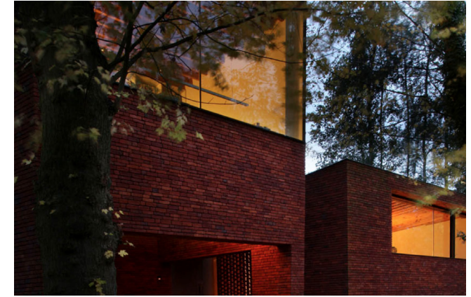
Afbeelding levendige gevel door spel met negges
