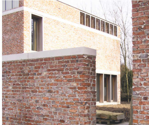
Afbeelding levendige gevel door voegwerk
