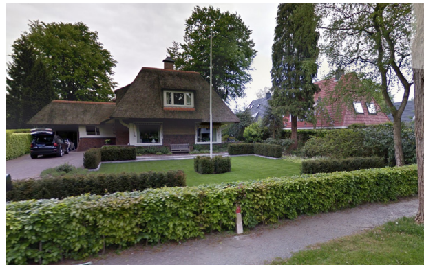
Afbeelding bebouwing Westerse Drift (bron: googlestreetview)
